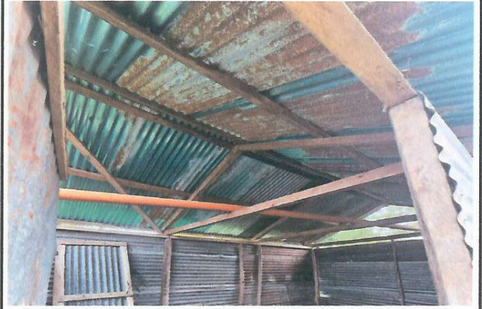
Foto 2: INSTALACIÓN DE LÁMINA TROQUELADA CALIBRE 26 Y ESTRUCTURA DEL TECHO
