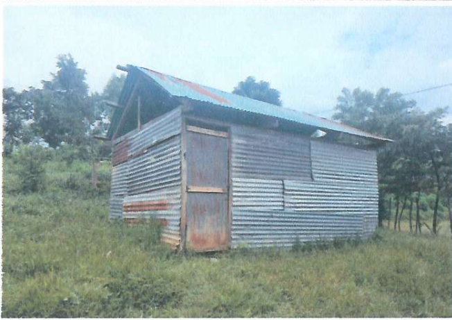
Foto 1: MEJORAMIENTO DE ESTRUCTURA TIPO PÓRTICO
